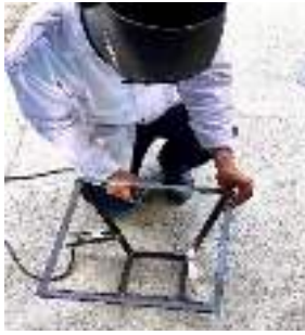
Fig. 6. Soldadura de lados de la tolva
