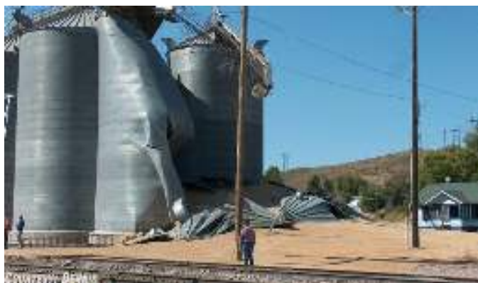
Fig. 2. La estructura del silo cedió y el cereal sepultó a los trabajadores.
