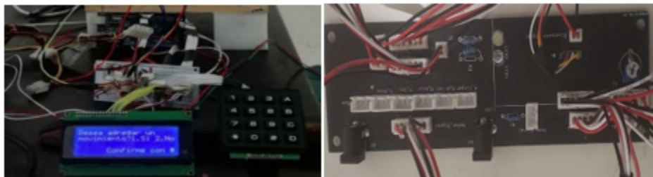
Ilustración 7 Distribución de cableado previamente existente en el brazo robot implementación de placa de circuito impreso. Fuente: Construcción propia
